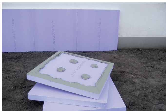
Photo 1: Isolation des socles avec JACKODUR® Gefiniert
