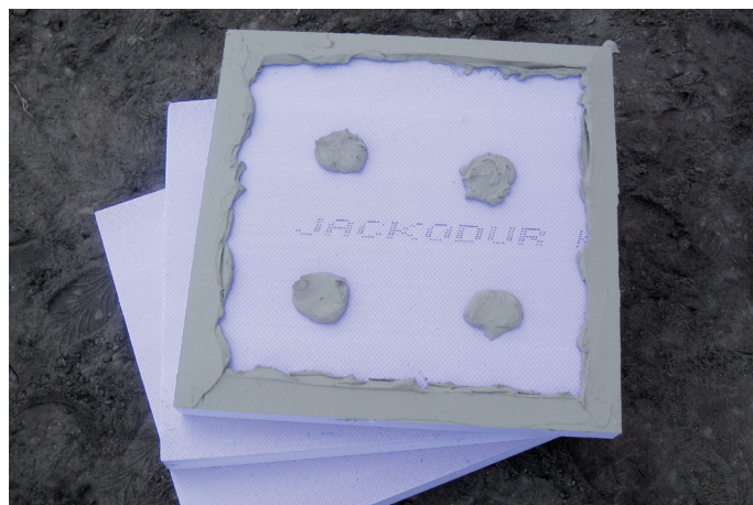
Photo 2: Isolation des socles avec JACKODUR® Gefiniert avec collage par plots
