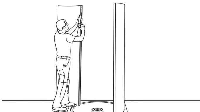
4) Le dispositif BOARD-FIX® est appliqué sur le côté long du 2ème élément mural.
