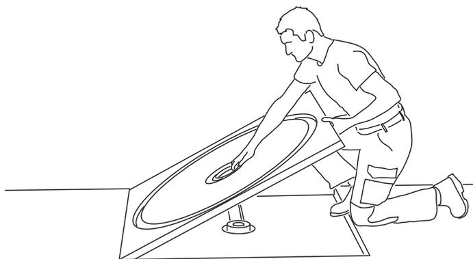
1) L'élément de sol doit être collé dans la réservation avec un mortier-colle de type C2. Le montage précis de l'élément de sol est décrit dans la notice de montage JACKOBOARD® Aqua/Aqua Flat.
