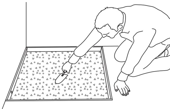
2) Appliquer le mortier-colle sur toute la face inférieure du receveur à l'aide d'une spatule dentée.
