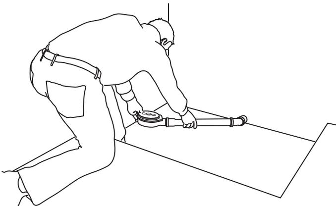
4) Raccorder le siphon au tuyau d'évacuation DN50 prévu selon les règles de l'art. Positionner le siphon à la bonne hauteur dans la réservation (voir la figure « Niveau de montage », pages 6 et 7).
